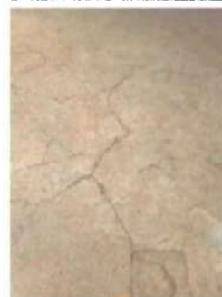
Foto 4: Reparación de losa de concreto para patios, considerando preparación de terreno, armado, nivelación y acabado rustico.
