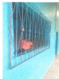
Foto 2: Mantenimiento a balcones metálico, lijado y pintura.
