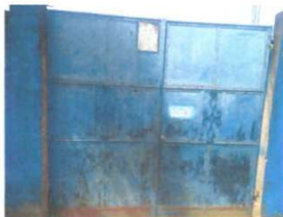
Foto 3: Mantenimiento a portón de ingreso, material: metálico, incluye: lijado y pintura.
